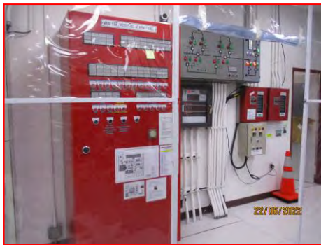
ภาพที่ 2.2-24 ตู้ควบคุมระบบดับเพลิงของโรงงาน
