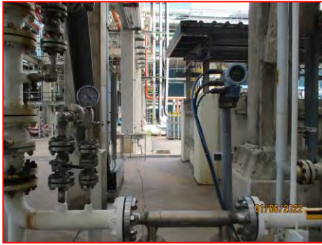
ภาพที่ 2.2-21 อุปกรณ์ควบคุมการไหล อุปกรณ์วัดความดัน และอุณหภูมิสัญญาณเตือนและวาล์วนิรภัย
