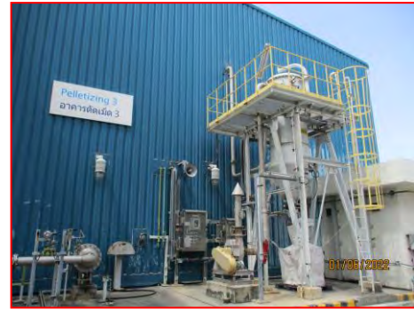
ภาพที่ 2.2-30 ระบบรวบรวมฝุ่นจากบริเวณที่มีการฟุ้งกระจาย ของสารเติมแต่งในอาคาร Pellet 3
