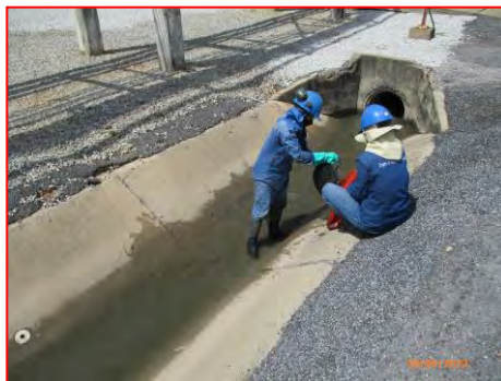
ภาพที่ 2.2-10 การทำความสะอาดรางระบายน้ำฝน
