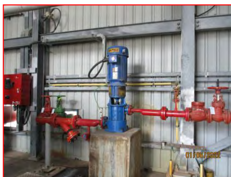
ภาพที่ 2.2-16 เครื่องสูบน้ำรักษาแรงดัน (Jockey Pump)
